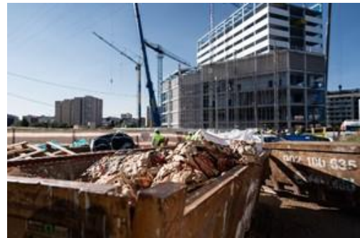
Papiersäcke und andere Abfallmaterialien werden auf der Baustelle in separaten Containern gesammelt. Copyright: EUROSAC
